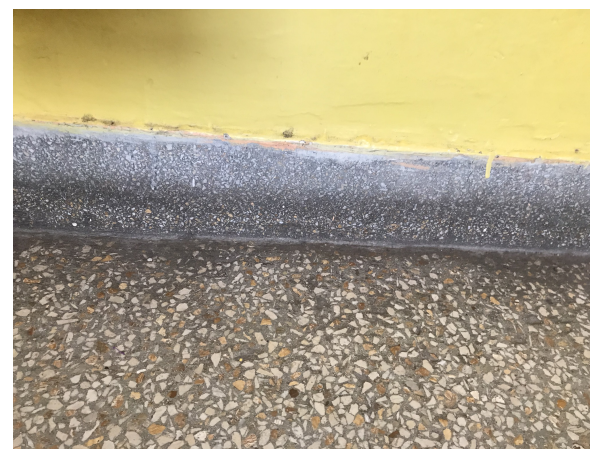
Stávající sokl z teraca před renovací
