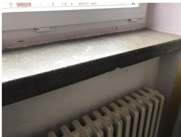
Stávající okenní parapet před renovací
