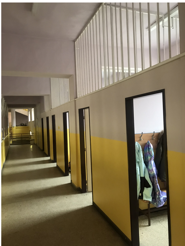
Stávající SDK příčky s dveřmi a mřížemi určené k odstranění
